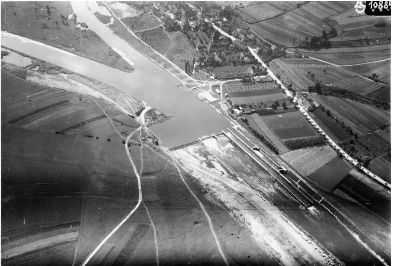
Abb. 2: Bischberger Wehr am Zusammenfluss von Main und Regnitz um 1920. Auf der rechten Seite der Anlage befindet sich die Kammerschleuse zur Einfahrt in den Bamberger Hafen, daneben die Floßgasse.
