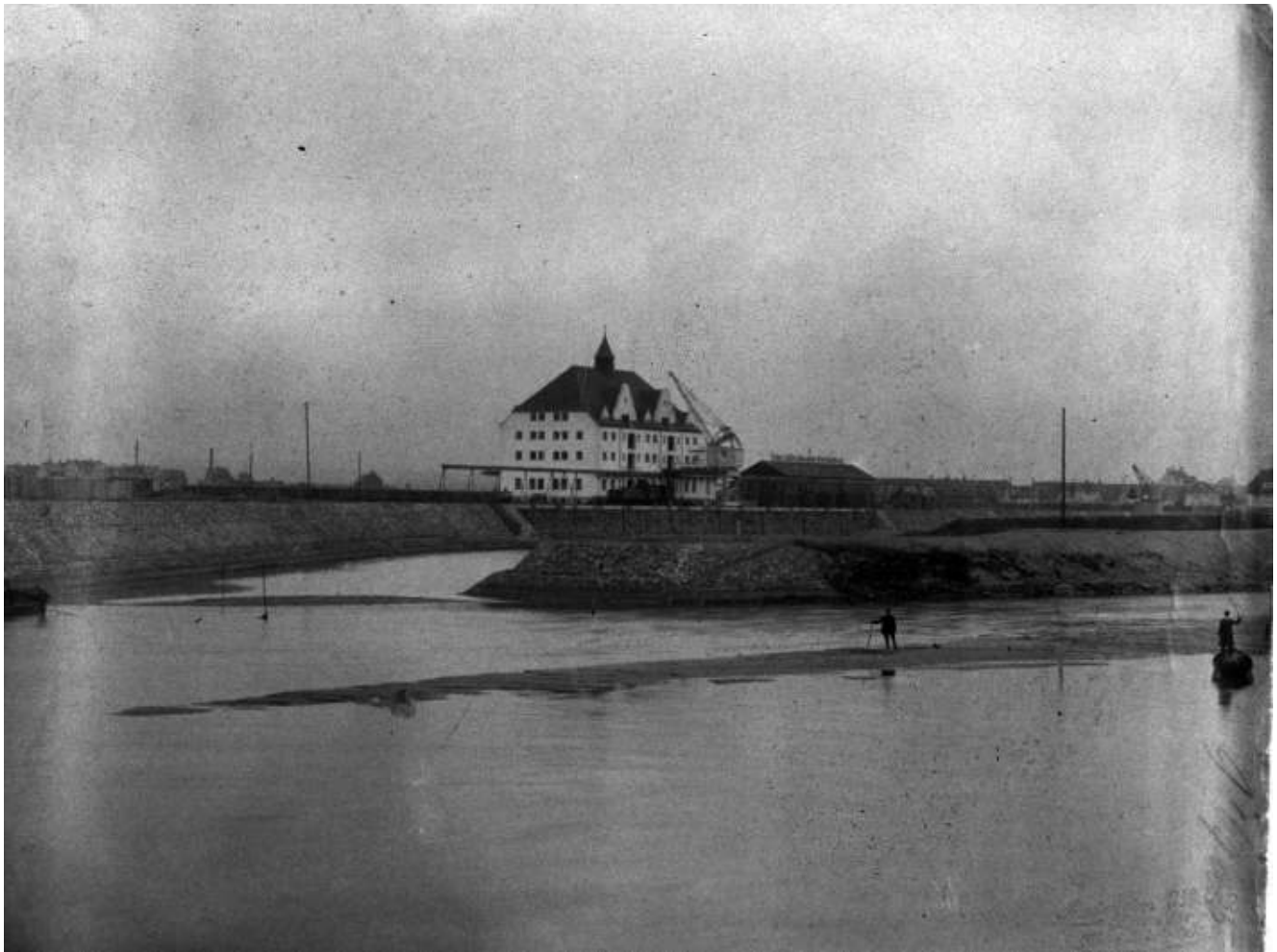
Abb. 5: Blick auf die Hafeneinfahrt des Prinz-Ludwig-Hafens in Bamberg mit dem Lagerhaus von 1912. Die Hafeneinfahrt sperrt die Versandung vom November 1912.
