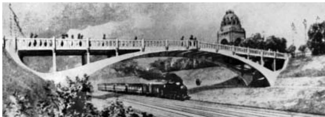
Die erste nach dem System von Friedrich von Emperger gebaute Brücke: Die „Fürst von Schwarzenberg-Brücke“ auf der Baufachausstellung in Leipzig 1913 (aus Deinhard, Massivbrücke)
