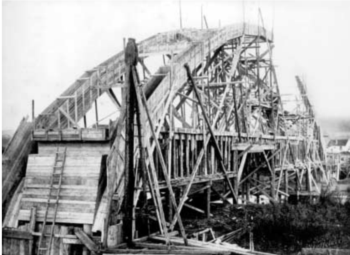
Lehrgerüst der Unterleiterbacher Mainbrücke von Westen, im Hintergrund das Fährhaus von Unterleiterbach (Foto J. Hospe, Staffelstein, Besitz Klaus Beyersdorf, Fa. O. Hauch, Coburg)
