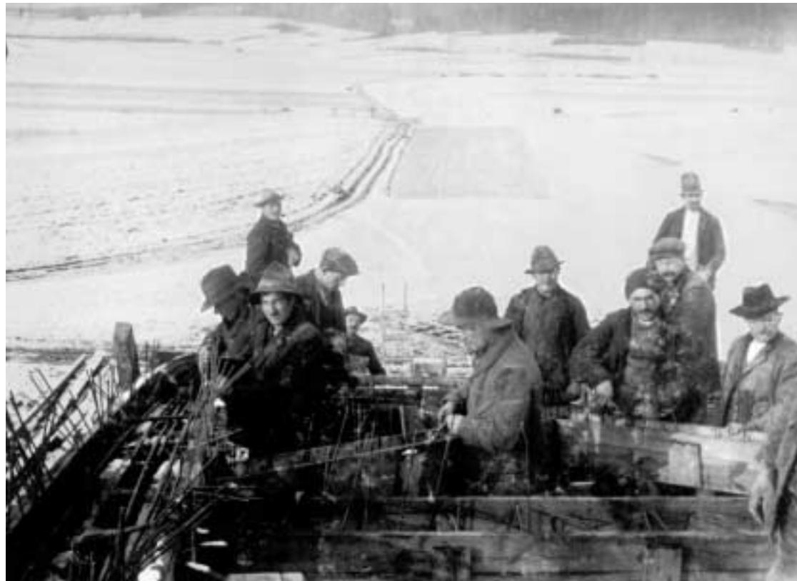
Arbeiter beim Eisenflechten auf dem Schalgerüst der Brücke im Winter 1913/14 (Besitz Klaus Beyersdorf, Fa. O. Hauch, Coburg)
