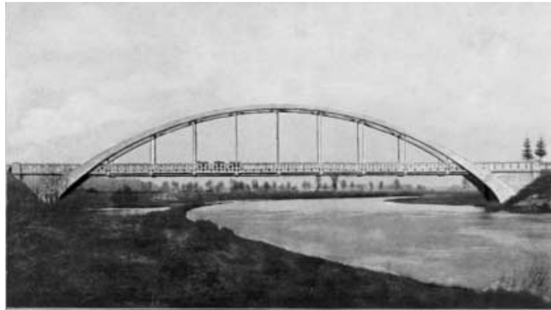
Unterleiterbach a. M. Eisenbeton-Brücke ü. d. Main, 53 m Spannweite, nach System Dr. v. Emperger Erbaut 1913/14. Thüringer Betonbaugesellschaft Otto Hauch & Co., Coburg
