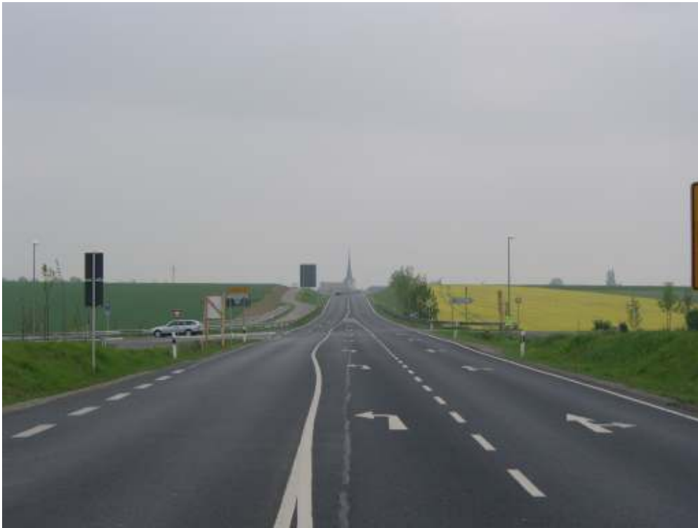
Abbildung 8: Die Kirche von Schnackenwerth als Blickpunkt in der Trasse der ehemaligen Chaussee Würzburg - Meiningen, heute B 19 . Foto: Thomas Gunzelmann
