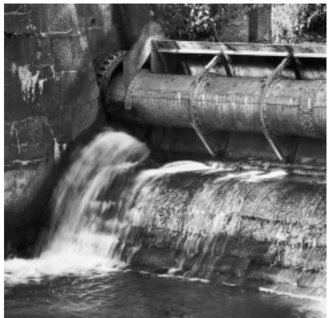
Walzenwehr, Küps, Landkreis Kronach; im Zuge der Rodachkorrektur von Küps um 1910 erbautes Walzenwehr, hier im Detail mit dem versteiften Eisenzyliner, dahinter der so genannte Stauschnabel der Wehrwalze
