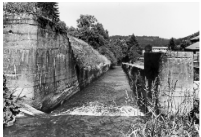
Untere Schleuse, Wallenfels, Landkreis Kronach; das um 1915 errichtete Bauwerk zur Überwindung des Höhenunterschiedes zwischen altem und neuem Rodachlauf besitzt die mit 75 m längste Floßgasse des Frankenwaldes
