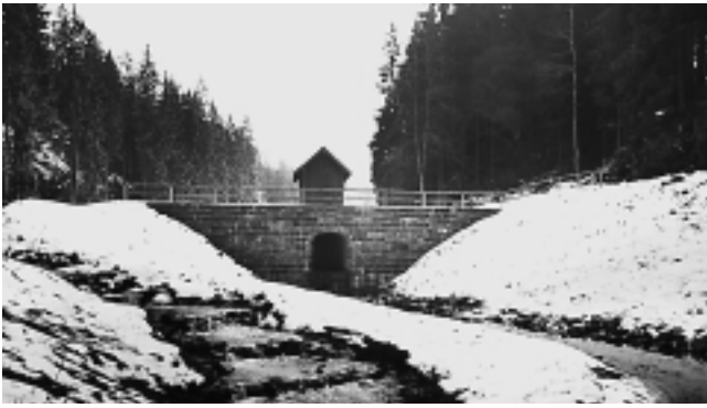
Bischofsmühlteich, Schwarzenbach a. Wald, Landkreis Hof; durch das Wasserwirtschaftsamt Hof in der Fassung des mittleren 19. Jahrhunderts rekonstruierte Staumauer des Bischofsmühlteiches an der Wilden Rodach, dem ältesten Floßteich des Frankenwaldes, der seit dem 15. Jahrhundert erwähnt wird
