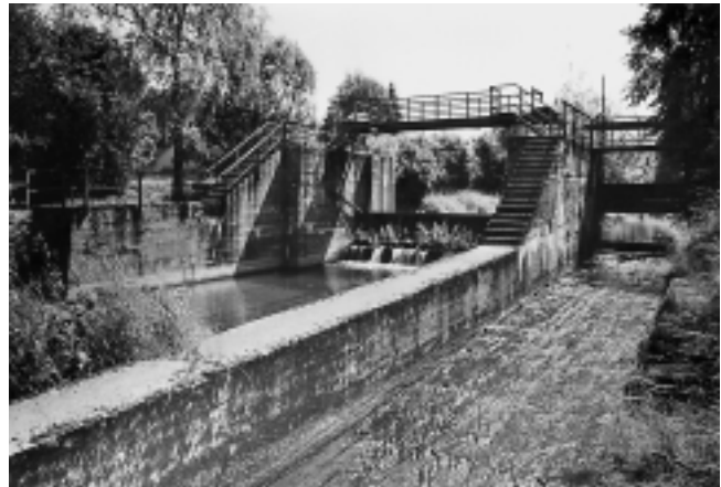
Obere Schleuse, Wallenfels, Landkreis Kronach; im Zuge der Rodachkorrektur von 1910–1915 errichtetes Segment- oder Fischbauchwehr mit Floßgasse
