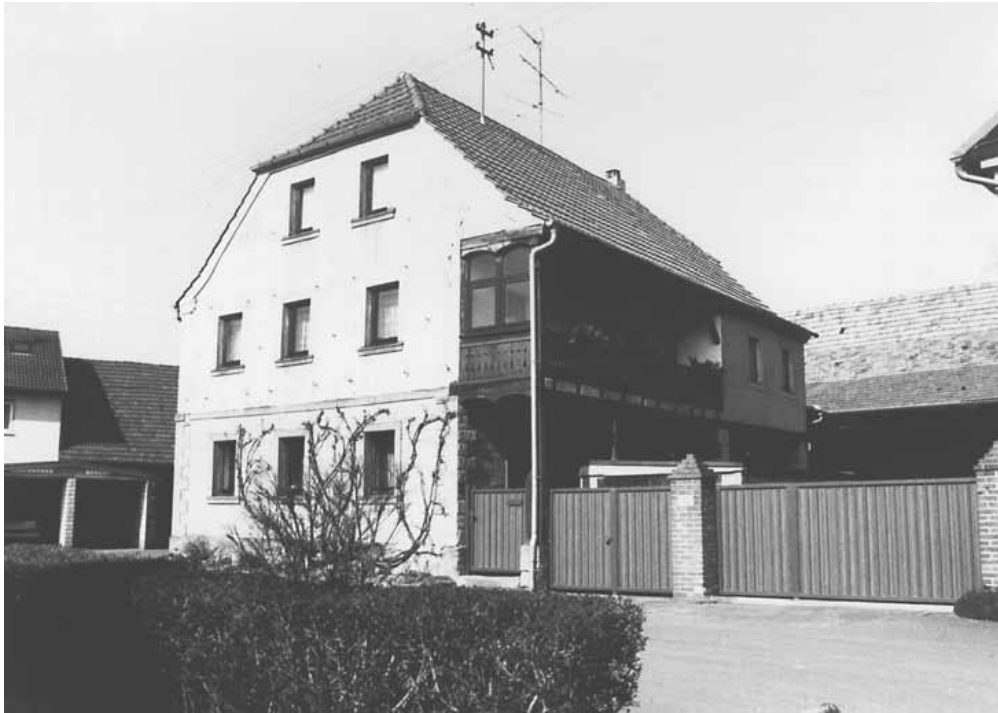
Abb. 3.19: Haus Nr. 24; zweigeschossiges Wohnhaus mit Krüppelwalmdach, massiv verputzt, zweigeschossige, eingezogene Laube, um 1920.
