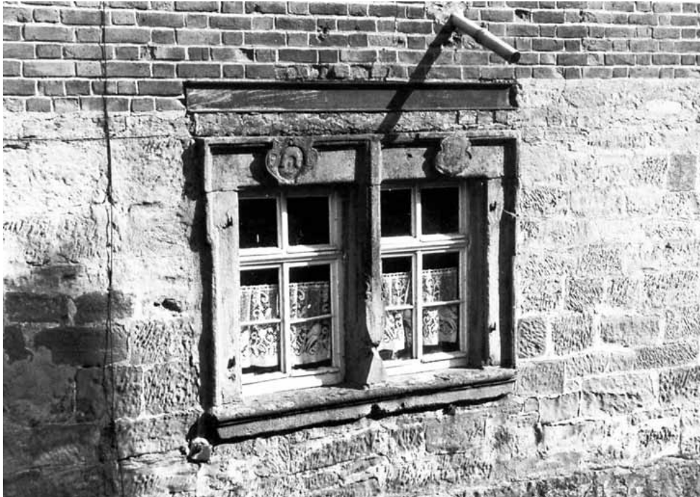
Abb. 3.42: Haus Nr. 61; Spolie, gekuppeltes und geohrtes Sandsteinfenstergerände mit Wappenschlußsteinen, 17. Jahrhundert, eingesetzt wohl 1897.
