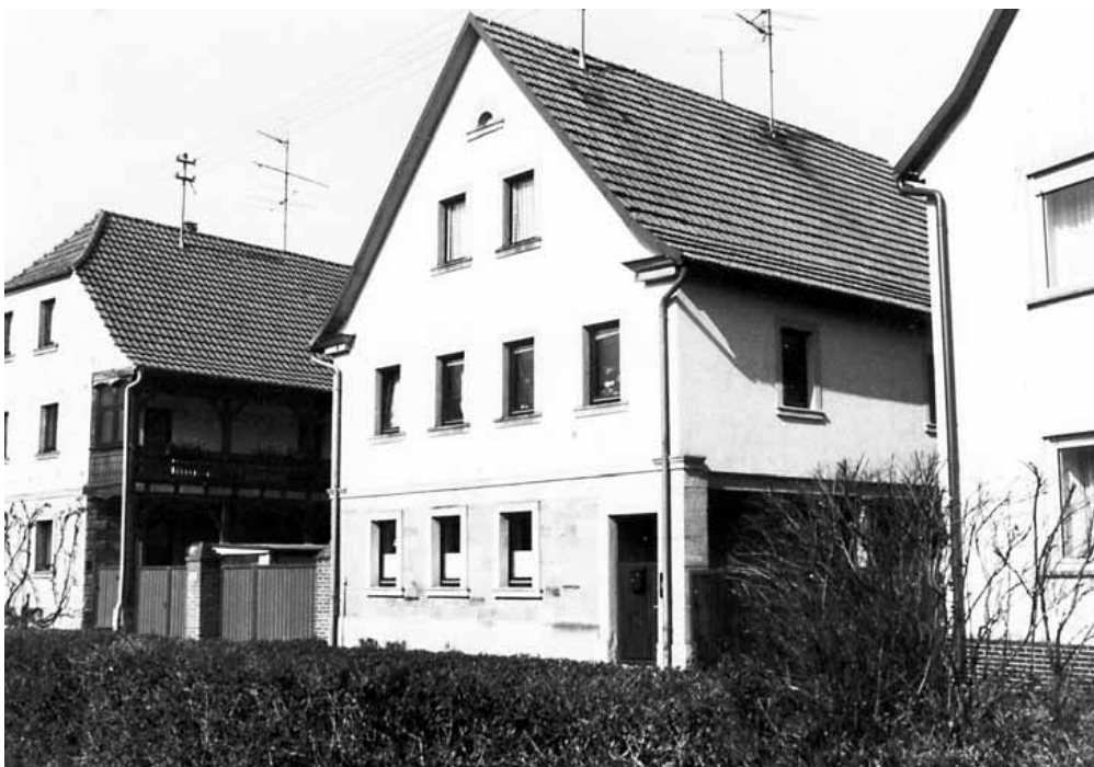
Abb. 3.18: Haus Nr. 25; zweigeschossiges Wohnstallhaus mit Satteldach; EG Werkstein, OG massiv verputzt, Eingezogene Laube im EG auf der Hofseite, ca. 1910.
