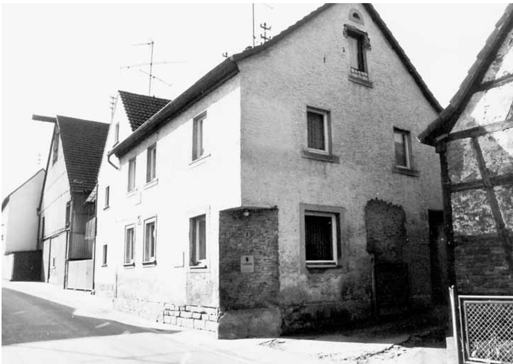
Abb. 3.14: Haus Nr. 2; zweigeschossiges Wohnhaus mit Satteldach, massiv verputzt, bez. 1905, um 1930 erweitert und traufständig gedreht
