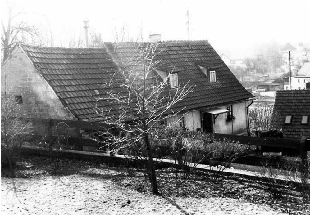
Abb. 3.39: Haus Nr. 52; erdgeschossiges Kleinhaus mit Satteldach, massiv verputzt in Firstrichtung angebaut Scheune, Mitte 19. Jahrhundert.
