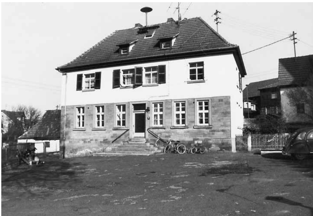
Abb. 3.36: Haus Nr. 50 – ehemalige Schule; zweigeschossiger Bau mit Walmdach; EG Werkstein, OG massiv verputzt, um 1920.
