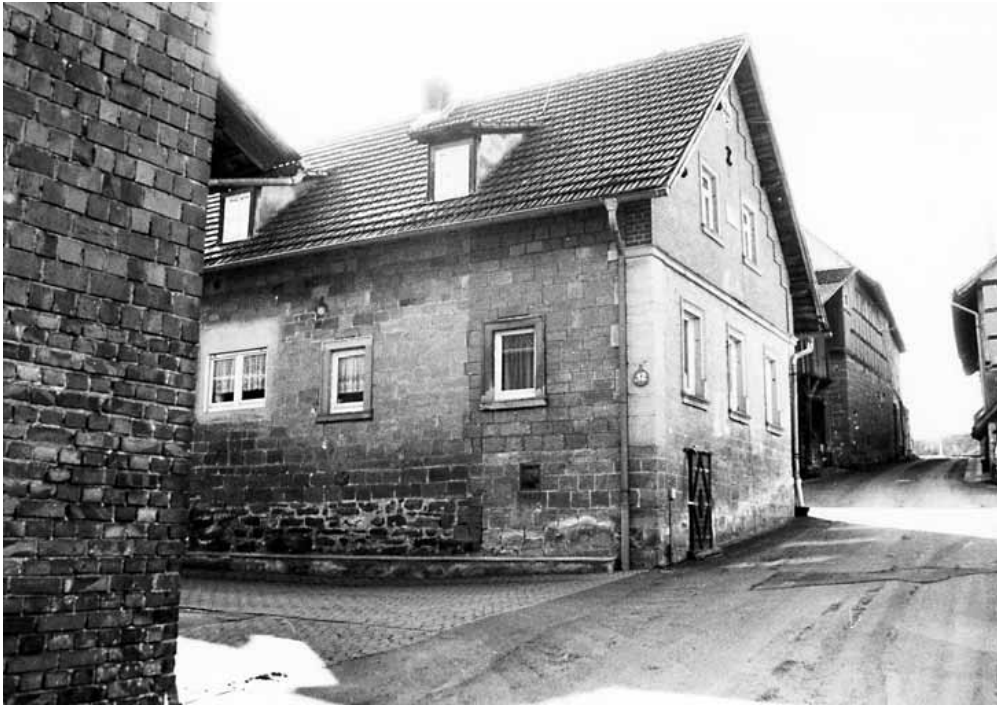
Abb. 3.23: Haus Nr. 12; gestelztes , eingeschossiges Wohnhaus mit Kniestock mit Satteldach, EG Sandstein, Giebel Ziegelsichtmauerwerk, bez. 1905 (zu diesem Zeitpunkt um eine Achse zur Straße hin verlängert, und mit neuem Dach versehen; im Kern 1. Hälfte 19. Jahrhundert)
