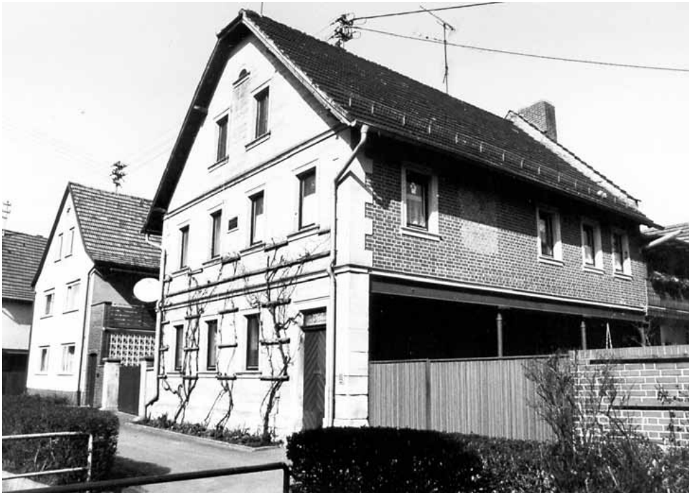
Abb. 3.16: Haus Nr. 27; zweigeschossiges Wohnhaus mit Schopfwalmdach, Giebel im Werkstein, Trauseite Ziegelsichtmauerwerk, hofseitig überbaute Laube im EG, OG auf Eisenträger und gußeisernen Stützsäulen, bez. 1907.
