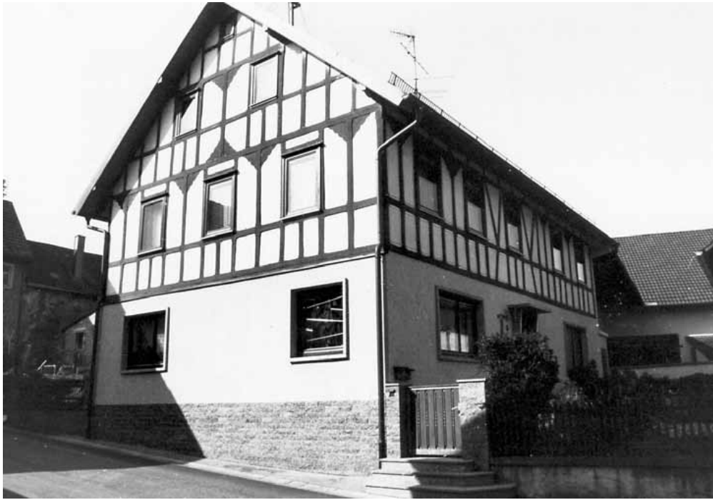
Abb. 3.21: Haus Nr. 16.; zweigeschossiges Wohnstallhaus mit Satteldach, EG massiv verputzt, stark verändert, OG Fachwerk, um 1910.
