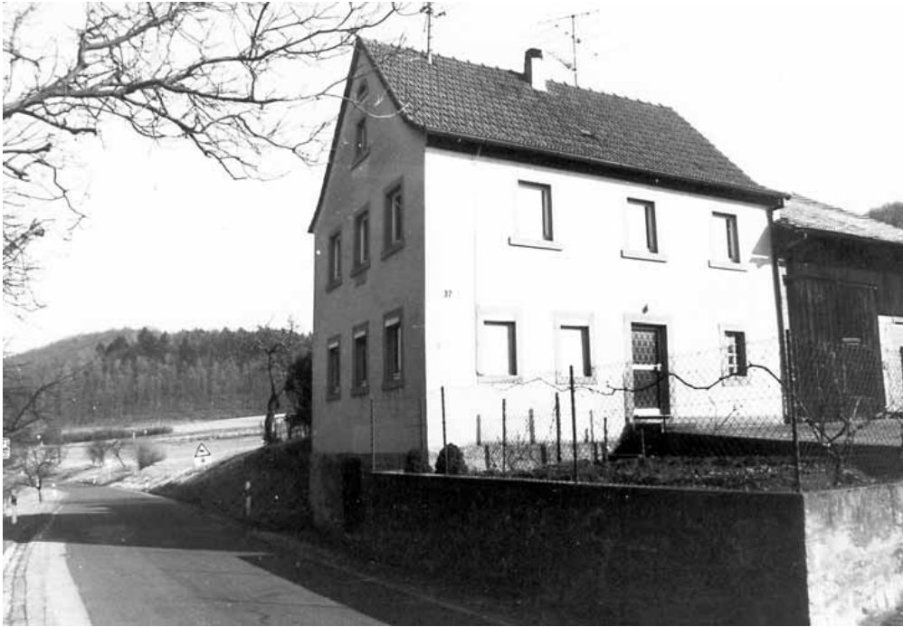
Abb. 3.33: Haus Nr. 37; zweigeschossiges Wohnhaus mit Satteldach, massiv verputzt, EG bez. 1888, OG 1933 aufgestockt.
