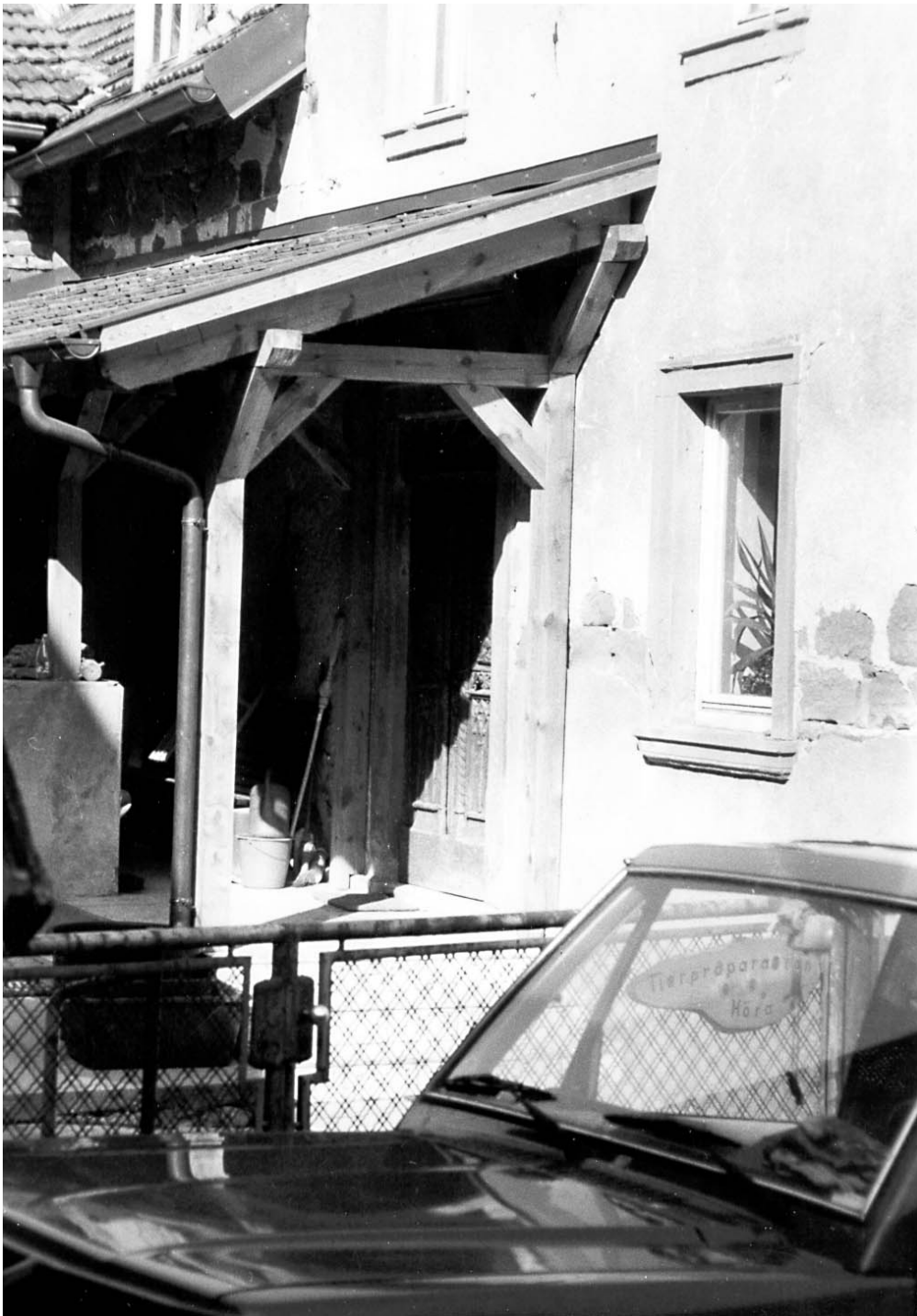
Abb. 3.41: Haus Nr.13; geschnitzte neugotische Haustür 1876.
