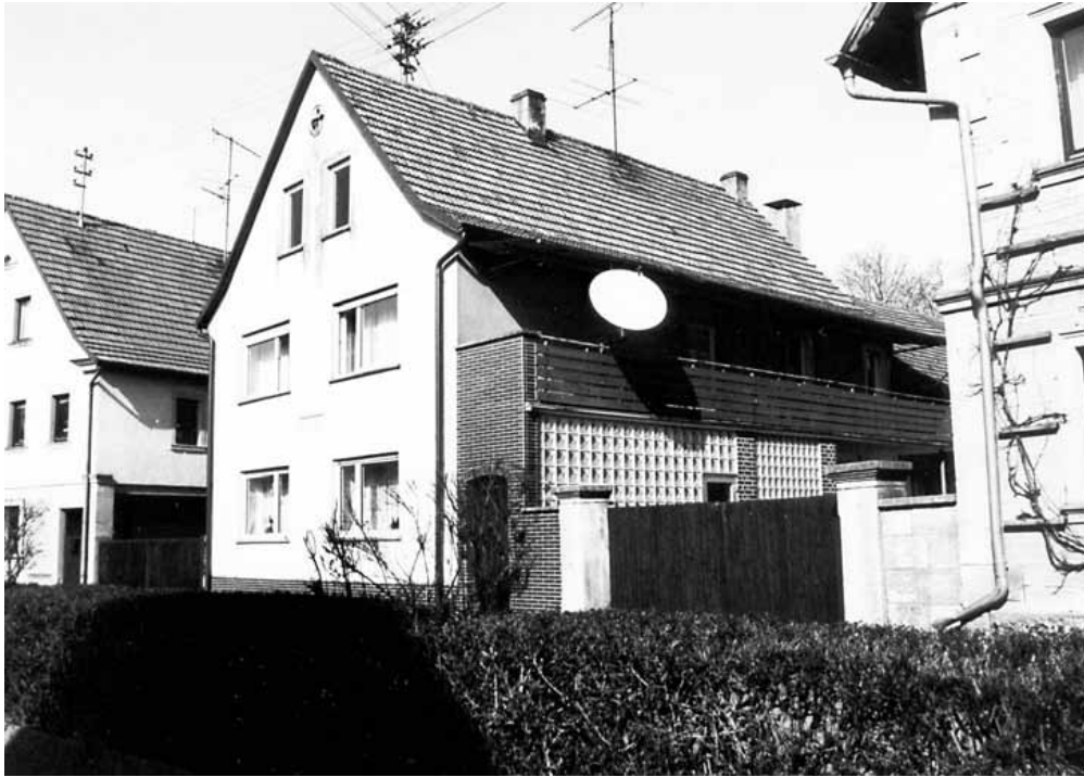
Abb. 3.17: Haus Nr. 26; zweigeschossiges Wohnstallhaus mit Satteldach, massiv verputzt, bez. 1934, zahlreiche Veränderungen.
