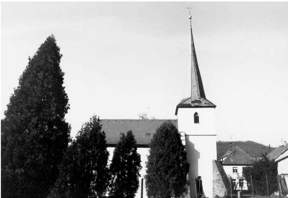
Abb. 3.12: Der Turm der Kirche stammt noch von der spätgotischen Anlage des 15. Jahrhunderts, der Turmhelm von 1687.
