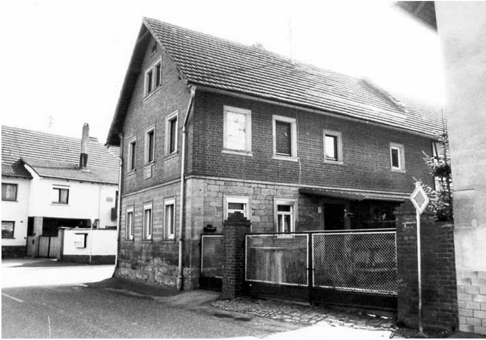
Abb. 3.15: Haus Nr. 3; zweigeschossiges Wohnstallhaus mit Satteldach; EG Sandstein, OG Ziegelsichtmauerwerk, bez. 1907.
