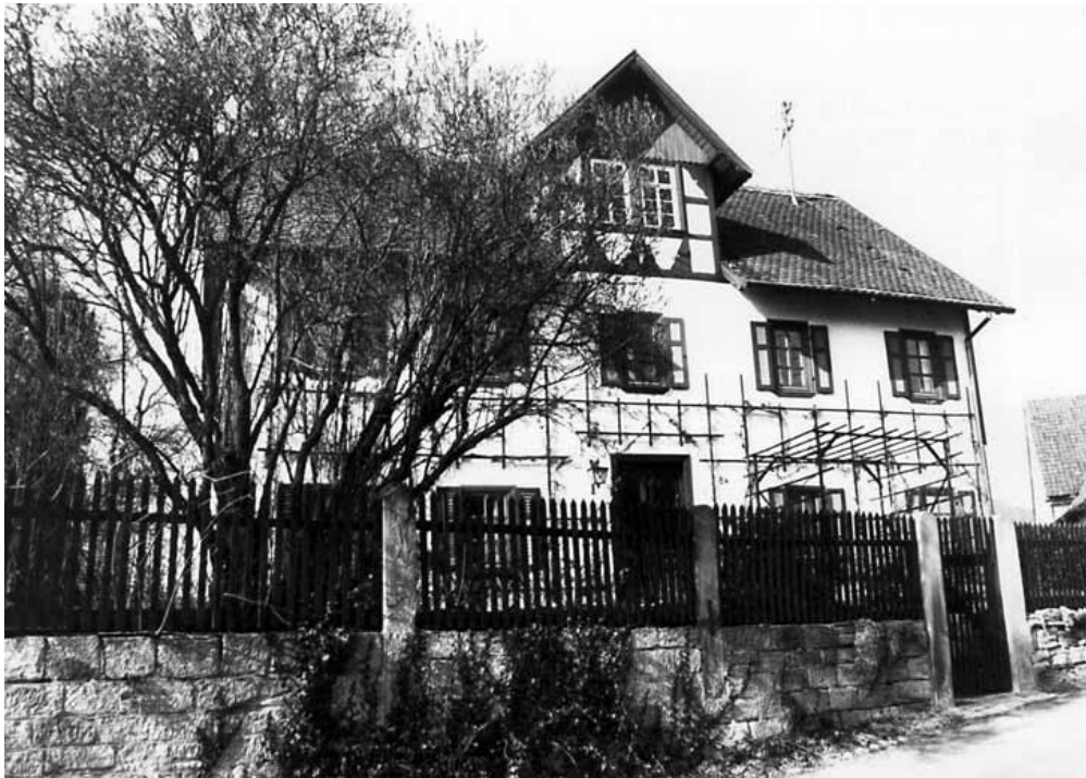
Abb. 3.31: Haus Nr. 34 (ehem. Forsthaus); zweigeschossiger Bau mit Satteldach und Zwerchhaus mit Fachwerk, massiv verputzt, um 1910.
