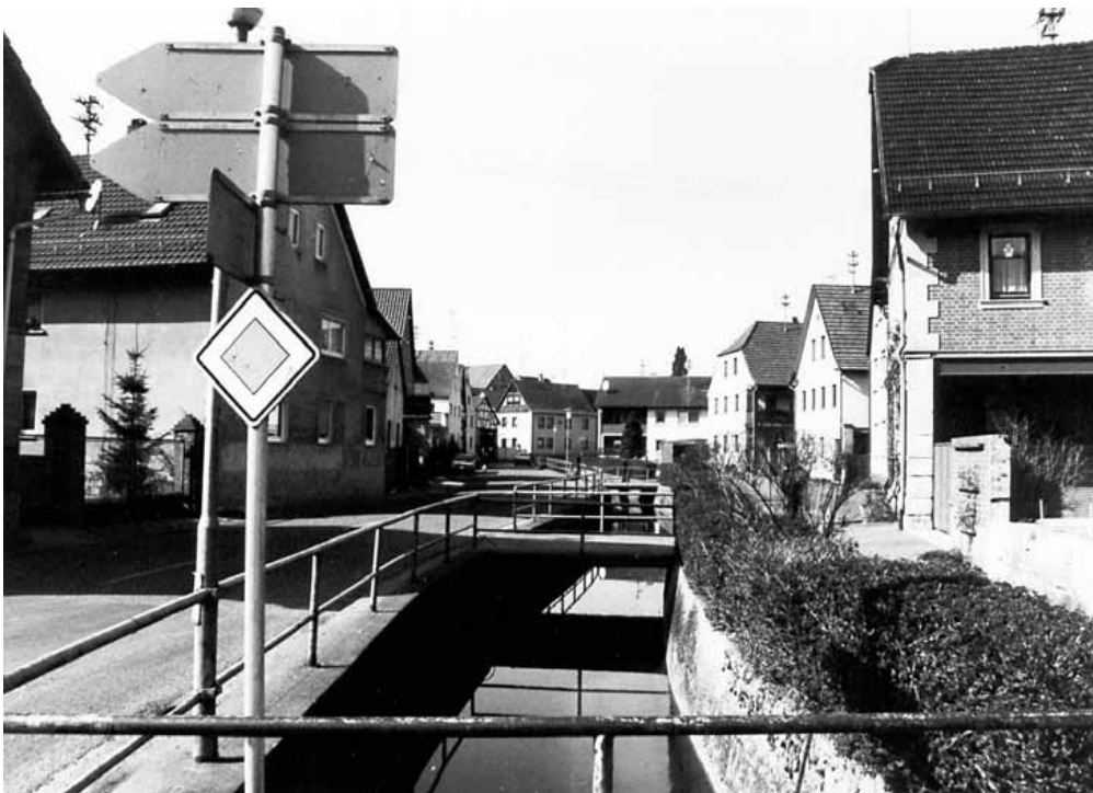
Abb. 3.4: Blick in die Dorfstraße nach Nordwesten. Der Straßenraum der Dorfstraße wird durch den gefaßten Bachlauf des Krumbaches bestimmt. Die ältesten Höfe des Siedlungskernes von Altershausen liegen hier im Bereich der angearteten Aufweitung meist giebelständig zur Straße. Auch wenn die Gestaltung der Bachfassung einem aktuellen dorfgemäßen Bachausbau nicht mehr entspricht, war der Bach auch im 19. Jahrhundert bereits gefaßt.
