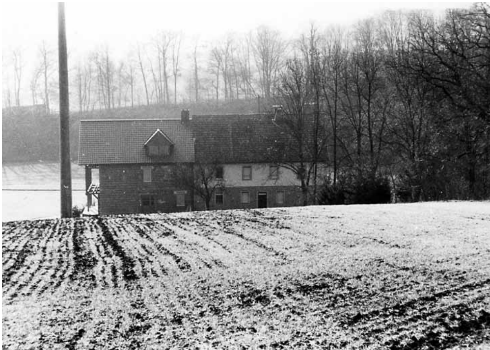
Abb. 3.35: 1. Mühle; zweigeschossiger Bau mit Satteldach, EG Sandstein, OG massiv verputzt, um 1900, neuer Anbau.
