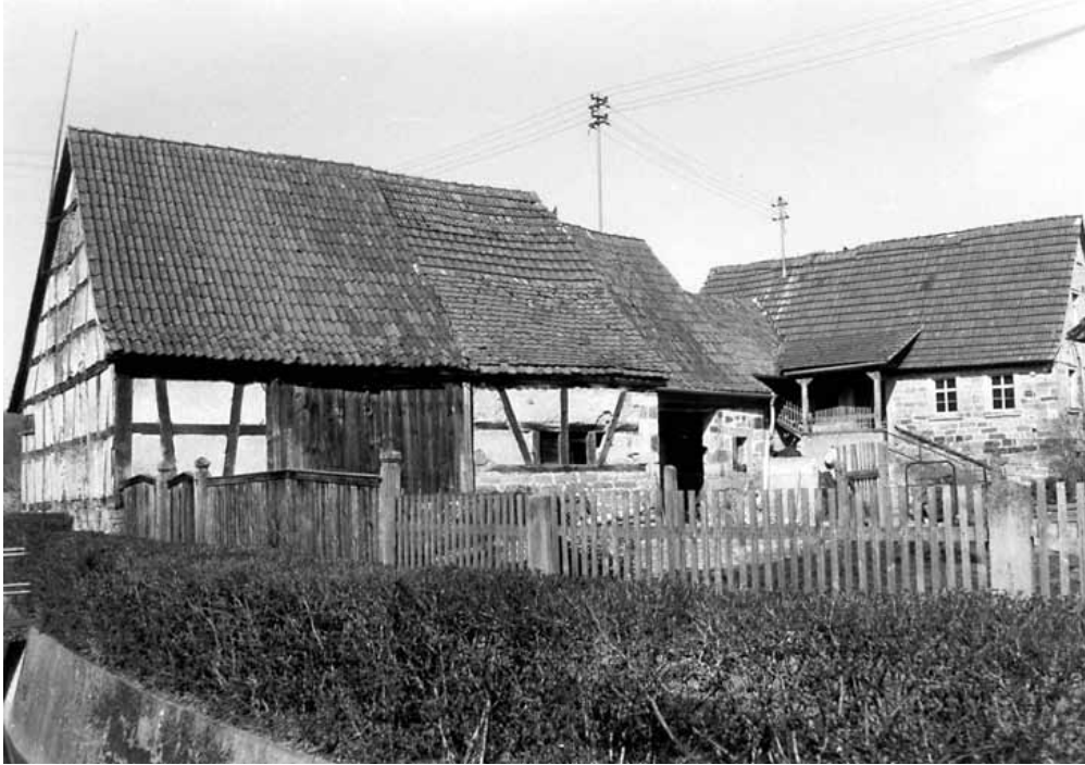
Abb. 3.25: Hofanlage Haus Nr. 20; Fachwerscheune mit Satteldach, z. T. mit Rinnenziegel, Remisen- und Stallbau, 18. und erste Hälfte 19. Jahrhundert, Holztoranlage.
