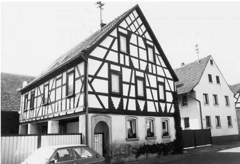
Abb. 3.26: Haus Nr. 7; zweigeschossiges Wohnstallhaus mit Satteldach und eingezogener, traufseitiger Erdgeschloßlaube, EG massiv verputzt mit Sandsteinfenstergewänden, OG Fachwerk, um 1910.
