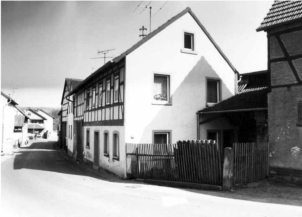
Abb. 3.13: Haus Nr. 75; zweigeschossiges Wohnhaus mit Satteldach, EG massiv verputzt, OG Fachwerk, um 1875
