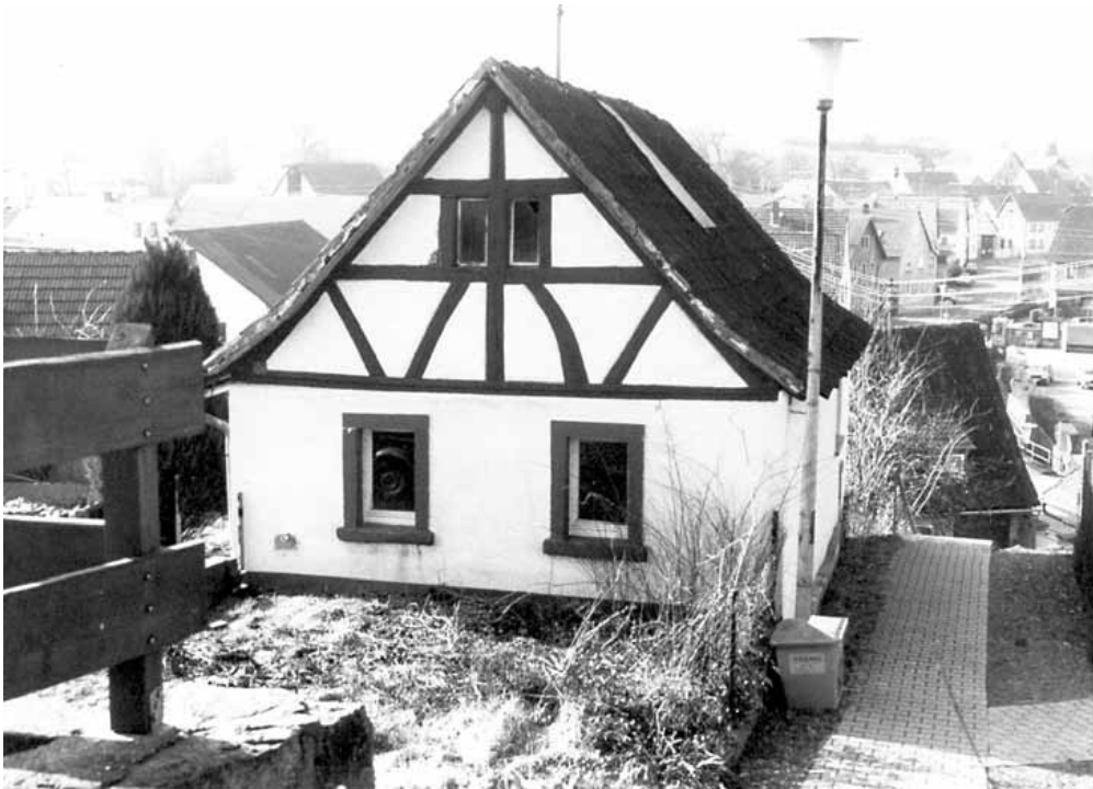
Abb. 3.37: Haus Nr. 55; erdgeschossiges Kleinhaus mit Satteldach; EG massiv verputzt, Giebel Fachwerk, 18. Jahrhundert, EG Mitte 19. Jahrhundert erneuert.
