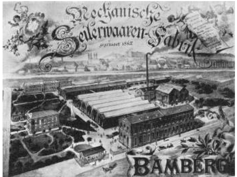
Abb. 1: Ansicht der »Mechanischen Seilerwarenfabrik« im ersten Betriebsjahr 1886. Links Kontorgebäude mit Wohnung des Vorstands, in der Mitte der Spinnereishedbau, anschließend Dampfkessel- und Dampfmaschinenhaus, dahinter der Seilereibau.
