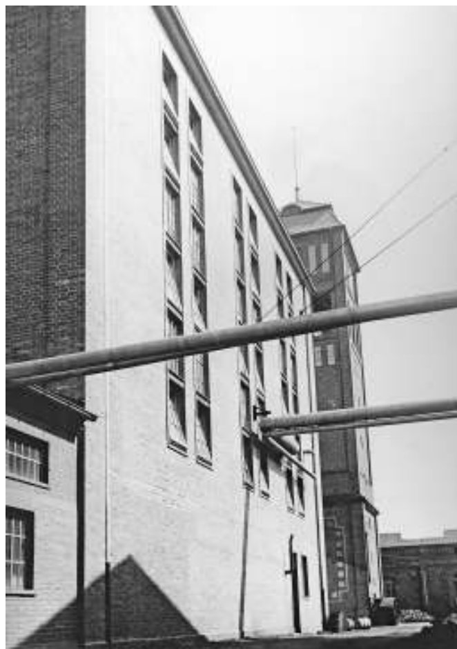
Abb. 8: Staubturm, 1908 von Chrysostomus Martin, links daneben das Kesselhaus.
