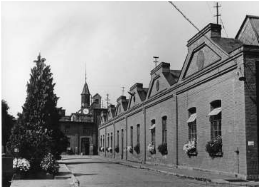
Abb. 5: Stirnseite des Spinnereiflachbaus, dahinter Dachreiter mit Werksuhr am Endpunkt der Eingangssache.
