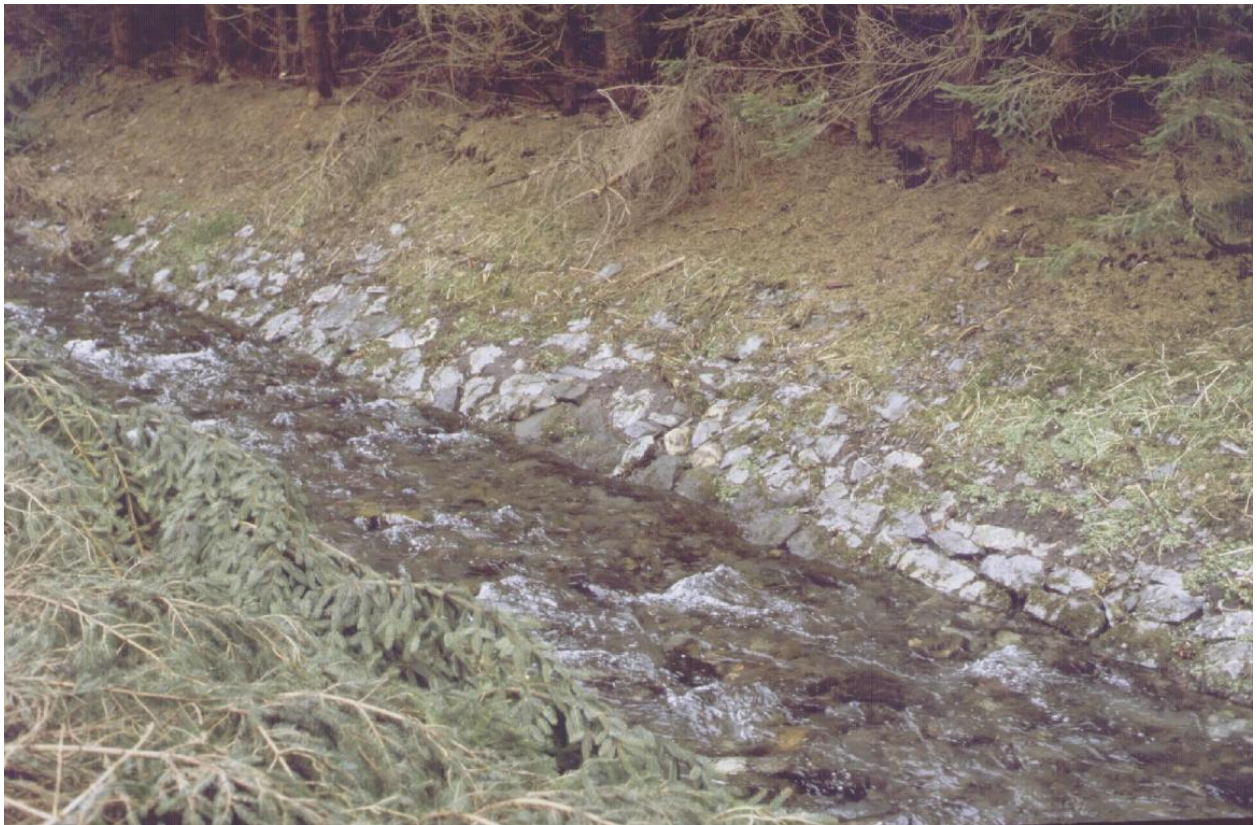
Abb. 3: Uferpflasterung des Lamitzbaches bei Wolfersgrün. Foto: Thomas Gunzelmann 2000
